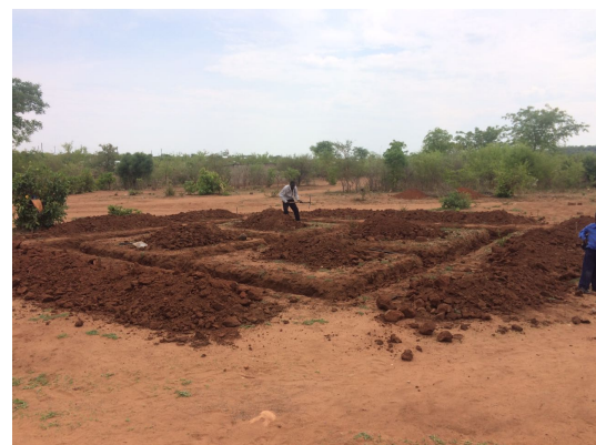
Beim Beginn des Baus von zwei neuen Klassenräumen im März 2017, halfen die Eltern der Schüler beim Ausheben der Fundamente.
